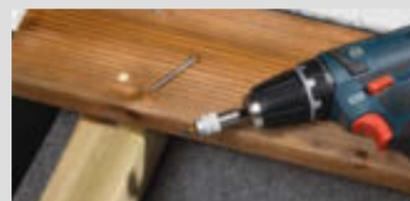
Danach richten Sie die Terrassendielen im rechten Winkel zur Unterkonstruktion aus. Dabei ist auf ausreichend Abstand zu festen Bauteilen wie Gebäudewänden oder Geländern zu achten. An den Kontaktpunkten von Unterkonstruktion und Diele sind zwei Verschraubungen erforderlich. Wir empfehlen, mit einem Senker die Löcher vorzubohren.
