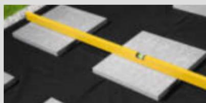
Als zweiter Schritt werden Stein- oder Gehwegplatten verlegt. Je nach Stärke und Holzart der Diele wird der Unterkonstruktionsabstand gewählt, dieser liegt zwischen 20 und max. 50 cm. Passen Sie den Abstand der Platten dementsprechend an. Kontrollieren Sie bitte nochmals das Gefälle.
